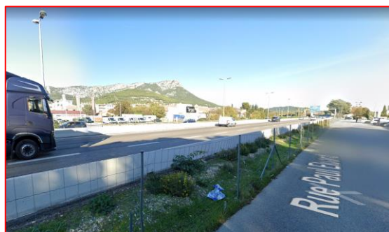
Eclairage du côté de l'autoroute A57
