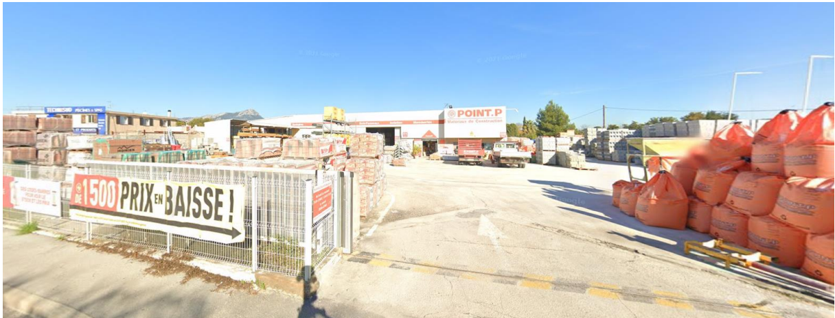
3- A l'Ouest, le magasin de dépôt de matériaux de construction.
