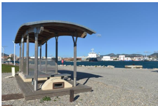
Figure 47 L'installation de thalassothermie vue de l'extérieur à la Seyne-sur-Mer
