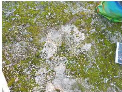
Sondage 6 : impossible à réaliser
