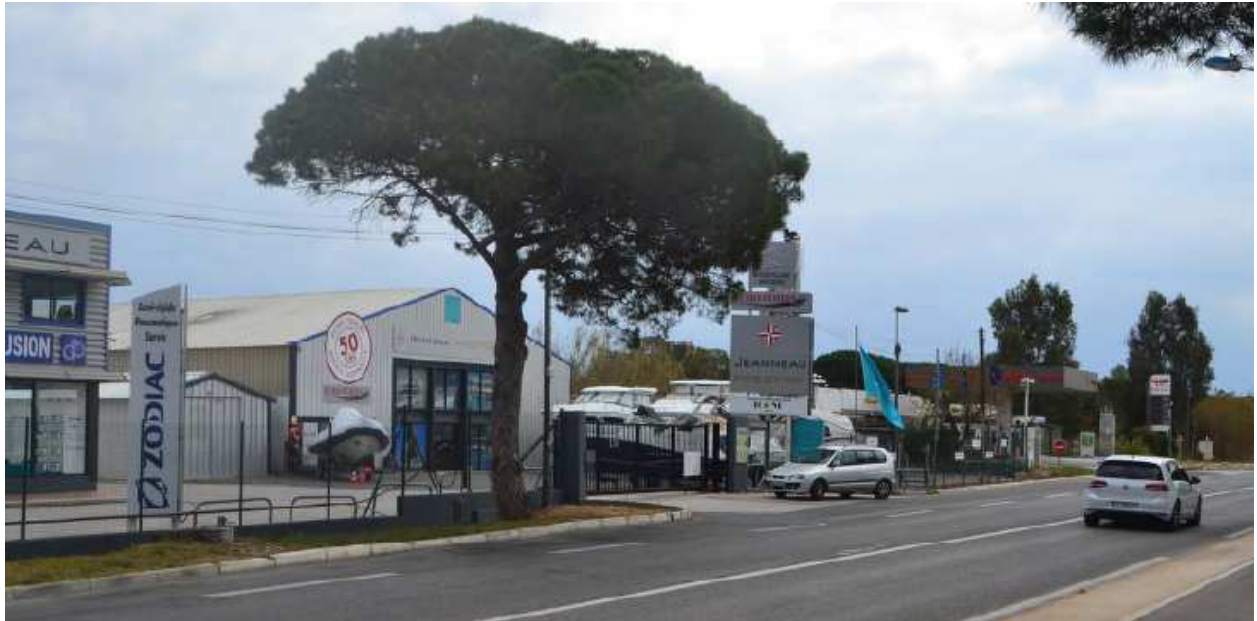
Vue 4 : état initial
